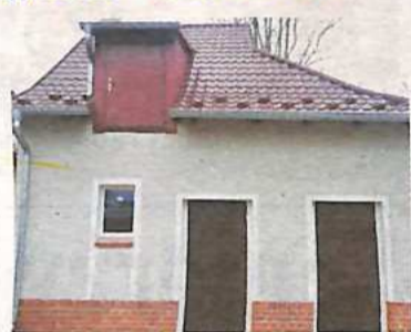
Kolejne budynki dworca PKP w Odolanowie zyskały blask.
