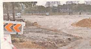
Trwają prace przy budowie parkingu.
