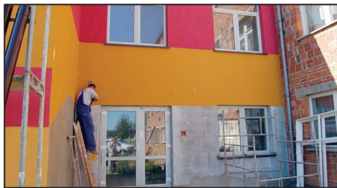
Następny etap budowy sali w Korytach
