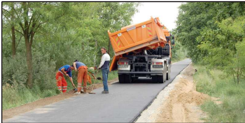
Budowa drogi w Korytach
