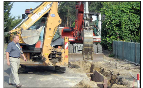
Budowa kanalizacji sanitarnej w Rąbczynie
