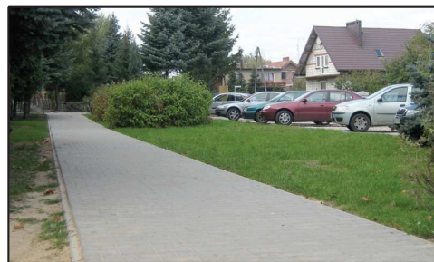
Nowy chodnik i parking przed szkołą w Raszkowie
